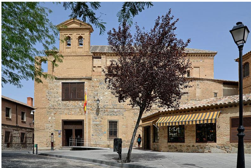
Sinagoga del Tránsito en la ciudad de Toledo
